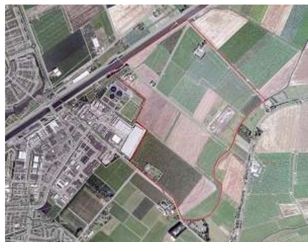
Ligging Kickersbloem 3 (rood omrand), met direct links ervan de rioolwaterzuiveringsinstallatie van waterschap Hollandse Delta
